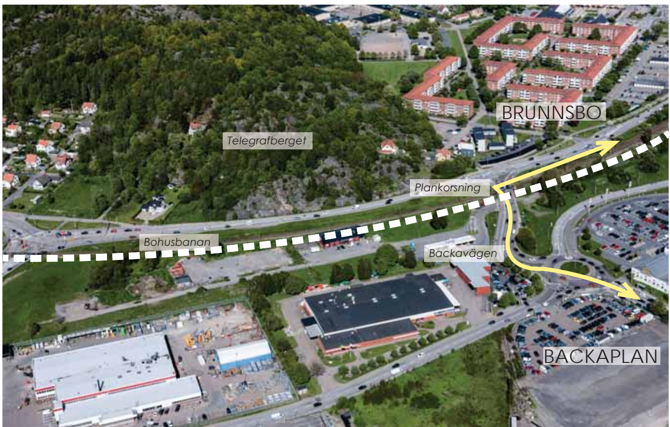
Vy från Backaplan i sydlig riktning.
